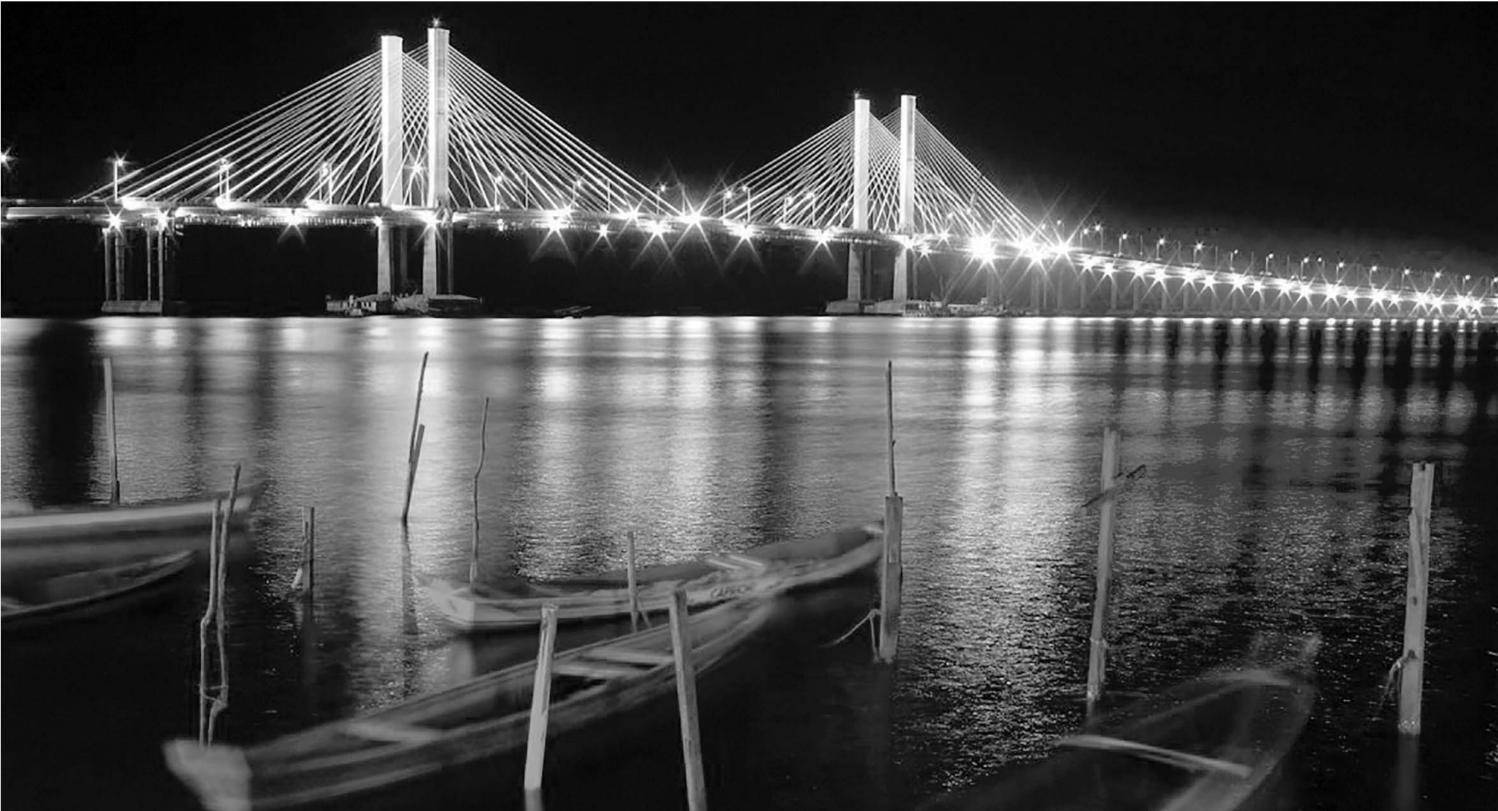
• Ponte Construtor João Alves liga Aracaju a Barra dos Coqueiros
