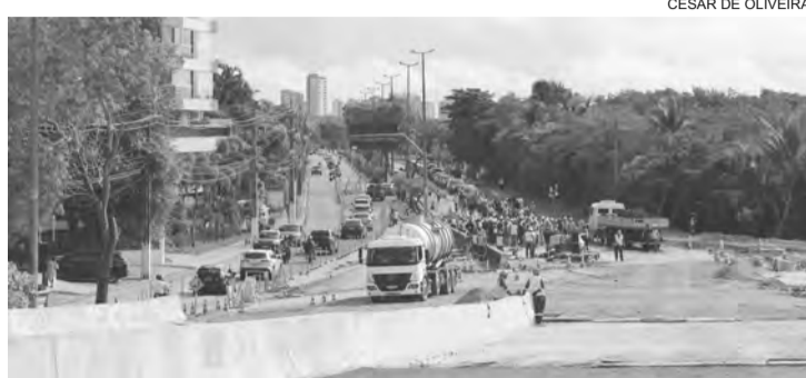
■ Governador vistoriou obra do viaduto do Complexo Viário Senadora Maria do Carmo Alves
